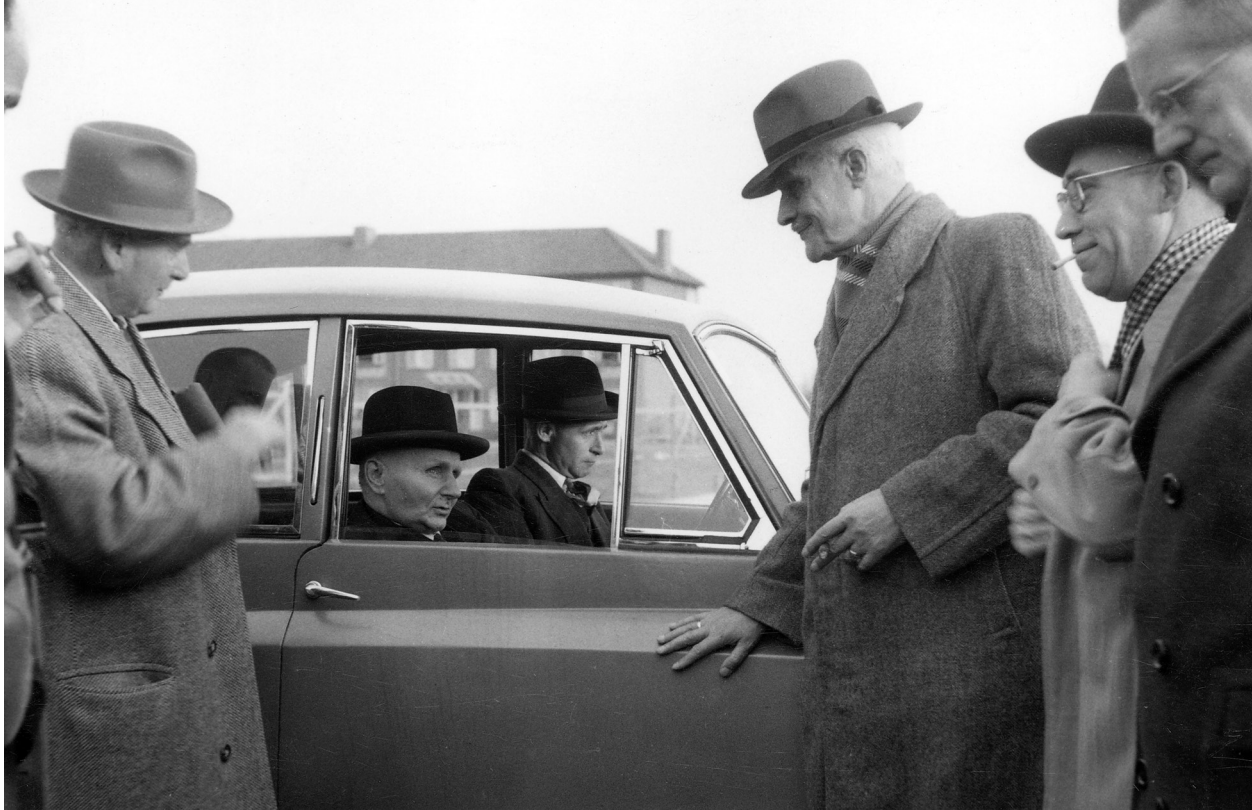
Aankomst van wethouder Kuijpers bij de start van een woningbouwproject aan de Lucas van Leydenstraat, 1953. (Foto: Stadsarchief, collectie Het Zuiden)
